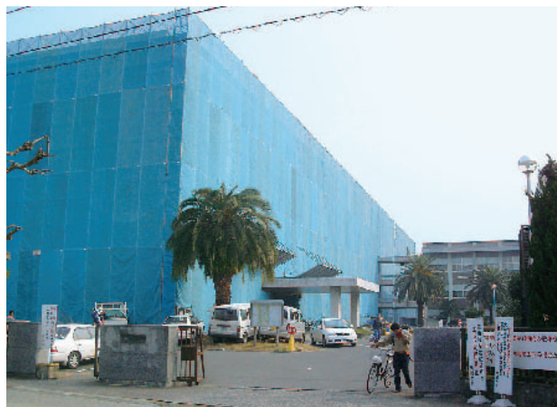
改修中の理学部本館
