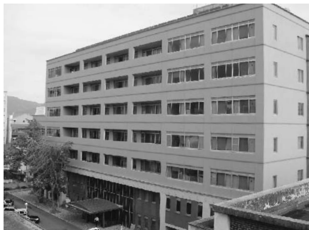
理学部と研究センターが利用している総合研究棟
