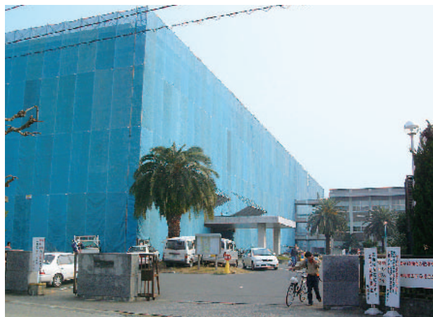
改修中の理学部本館
